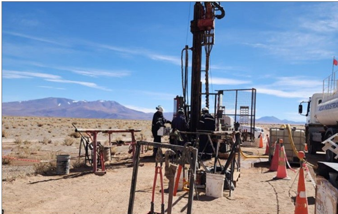
Figura 7-1: Construcción del piezómetro - perforación del pozo
