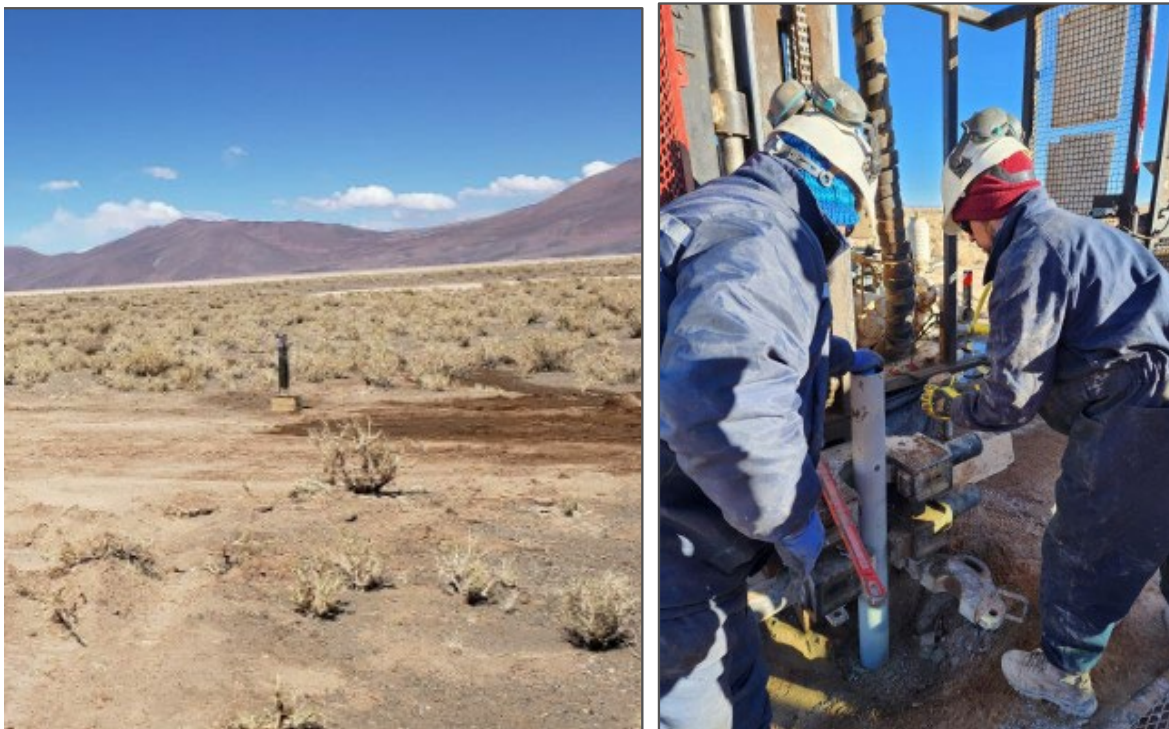
Figura 7-1: Construcción e instalación del piezómetro
